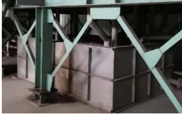
轧机油雾洗涤废水收集槽
